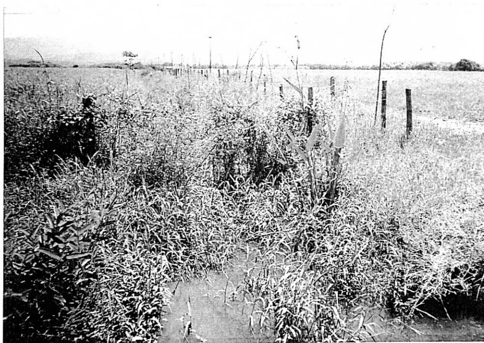
Foto 21. Km. 8+440 - margen derecha. Canal obstruido y presencia de aguas estancadas.
