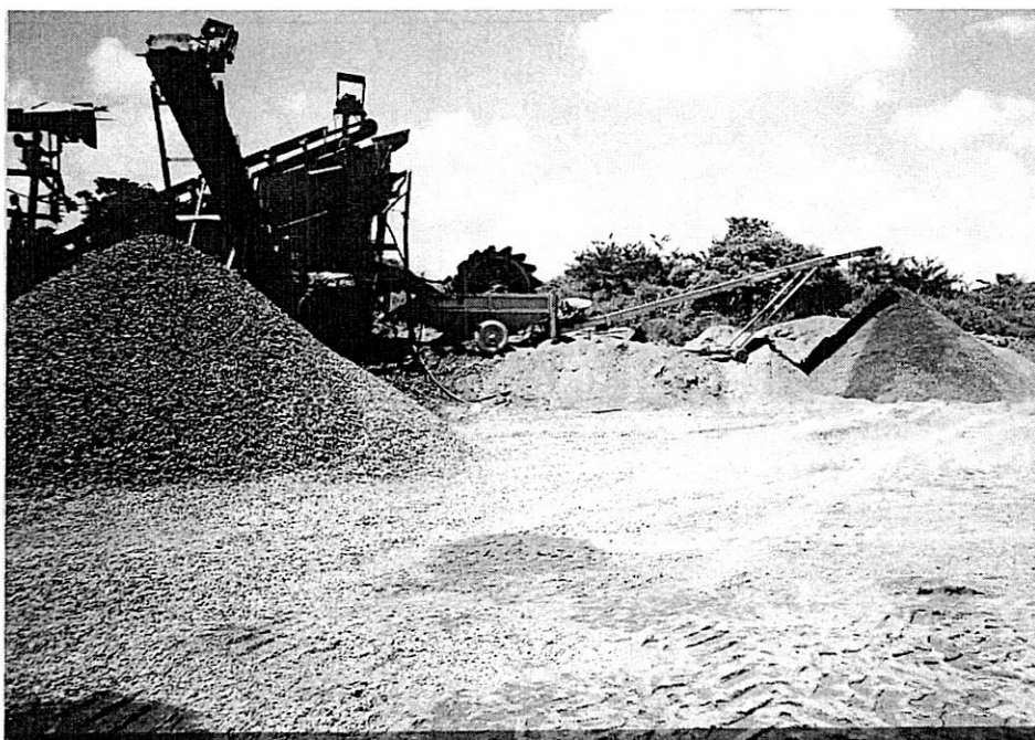
Foto 66. Equipo de triturado y selección del material - Concretos de Occidente.
