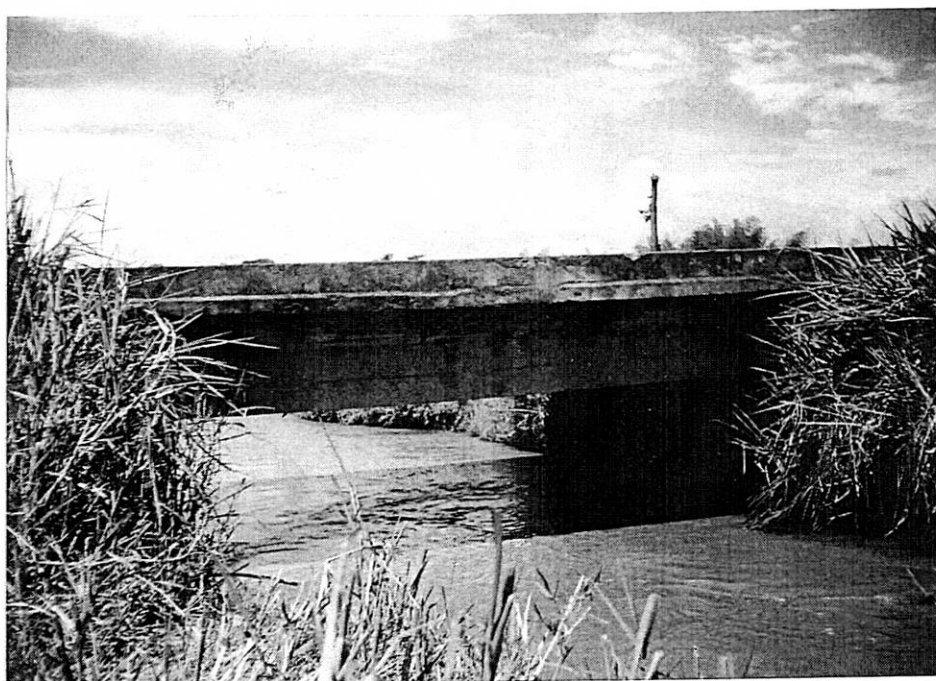
Foto 11. Km. 9+732. Río Guachinté. Pontón en buen estado.
