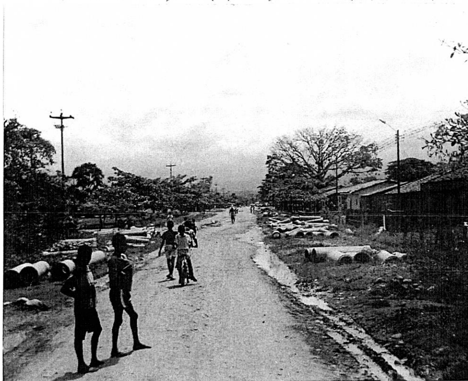
Foto 52. Quinamayó. Deficiencias en el sistema de alcantarillado.
