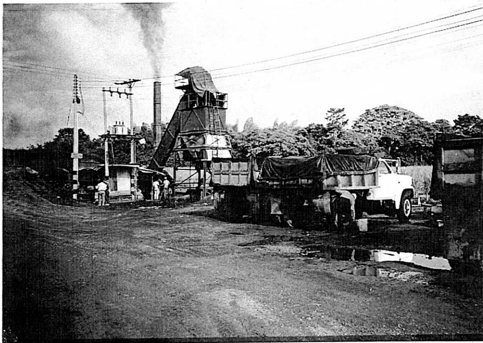
Foto 64. Vista de planta asfáltica - CONALVIAS.
