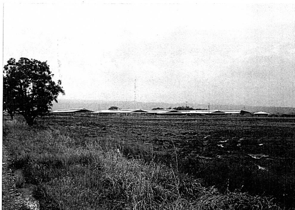
Foto 33. Km. 12+082 - margen derecha. Galpones para avicultura en construcción.
