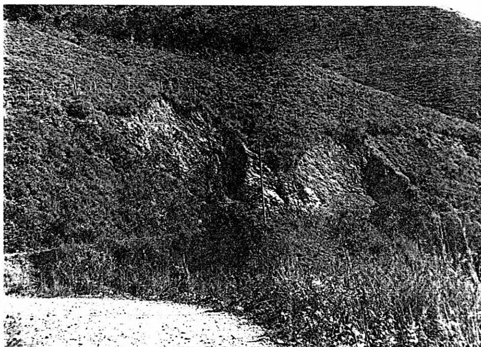
FOTO No. 35. Siguiendo por la vía Restrepo-La Cumbre, cerca al K 10, se encuentra una pequeña cantera en la que se explota un material de mala calidad (geotécnicamente). La zona es de alta pendiente, muy susceptible a deslizamientos y caída de rocas. Adicionalmente se encuentra muy cerca del río Grande y a la banca de la carretera.
