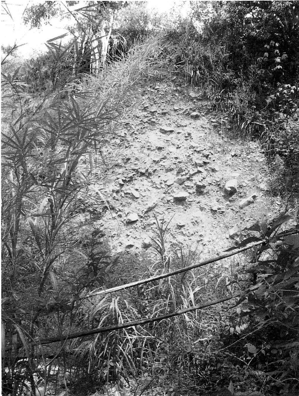
Cruce de quebrada, Conducción #2, tubería aérea
