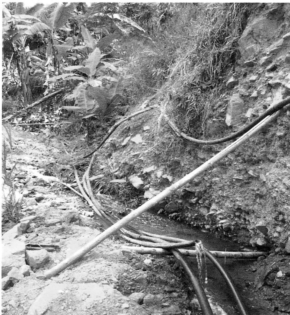
FIGURA 2.1.4, CONDUCCIÓN AGUA EN TRAMO DE CANAL NO REVESTIDO, QUEBRADA LA RECOMPENSA
