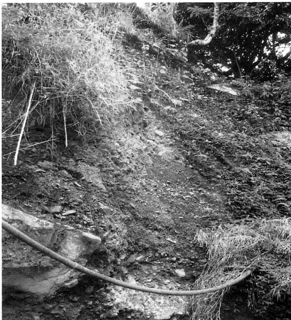
FIGURA 2.1.5 TRAMO DE CONDUCCION EN EL PIE DEL TALUD Y DENTRO DEL CAUCE DE LA QUEBRADA
