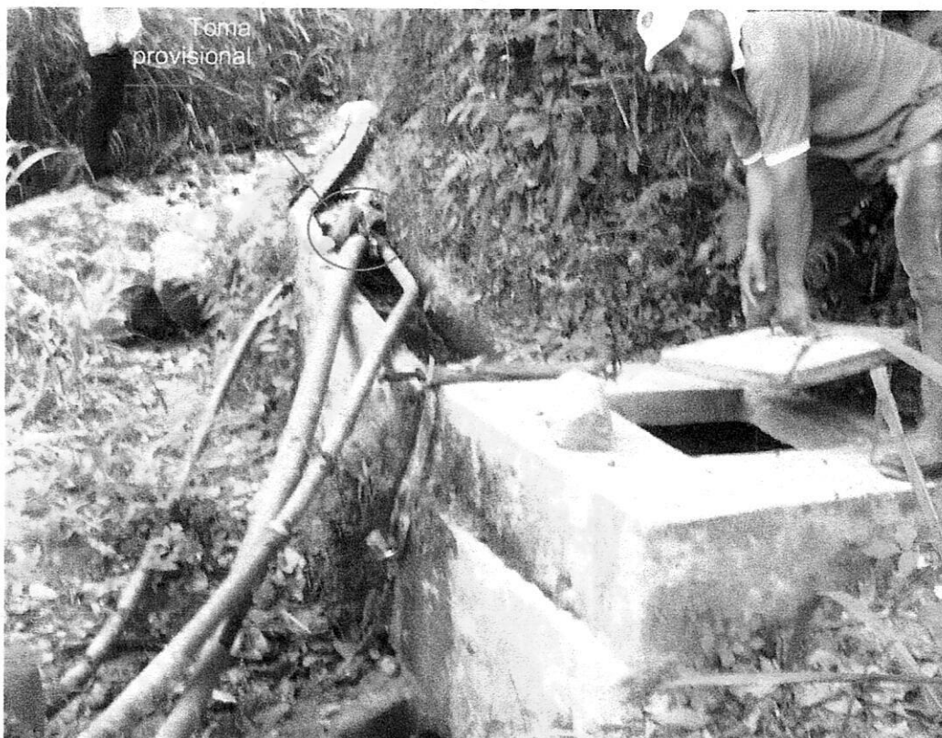
FIGURA 2.1.3 CONEXIÓN PROVISIONAL DE MANGUERAS AL CANAL DERIVACIÓN, BOCATOMA.
