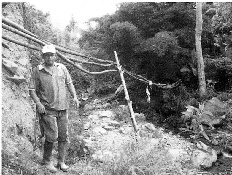
FIGURA 2.1.6 LOCALIZACIÓN CRUCE #1 TUBERIA AEREA, ACUEDUCTO GRANJA DEPARTAMENTAL.
