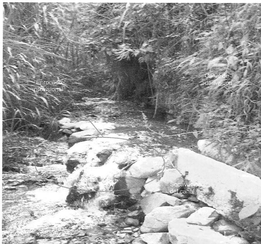
FIGURA 2.1.1. LOCALIZACIÓN DE LA BOCATOMA, CANAL DE DERIVACIÓN QUEBRADA LA RECOMPENSA
