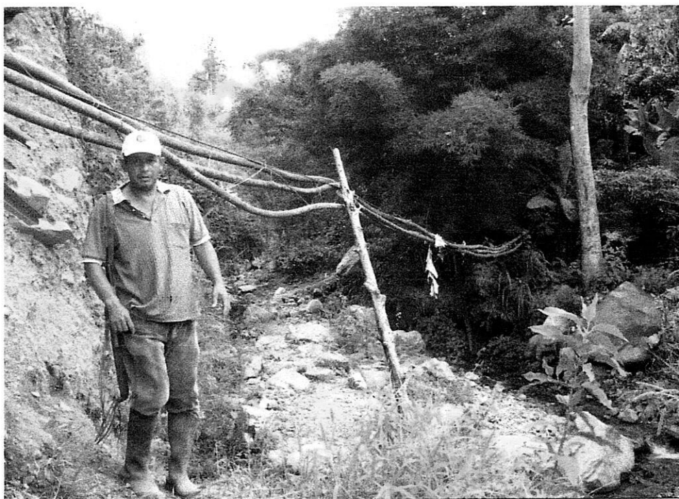
Cruce de quebrada, Conducción #1, tubería aérea
