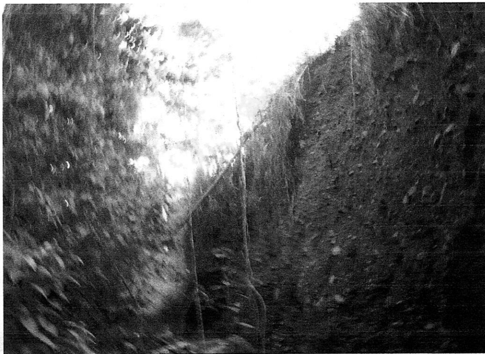
Taludes potencialmente inestables y propensos al deslizamiento
